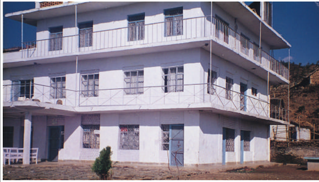
돌카지역 가우리상카병원 전경 - 1991
